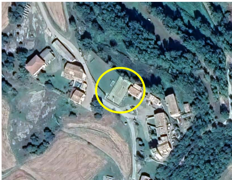
Fig. 1 Ubicació instal·lació fotovoltaica, indicada en groc.
