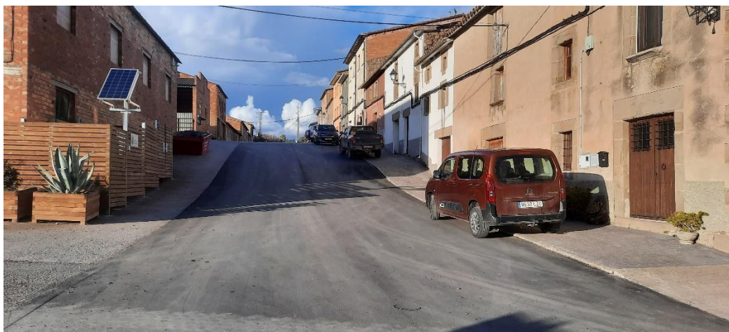
Figura 3. PK0+130 travessa calçada aglomerat asfàltic
