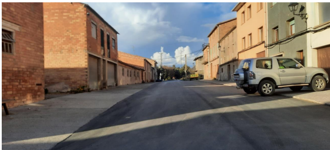
Figura 2. PK0+080 acera de formigó
