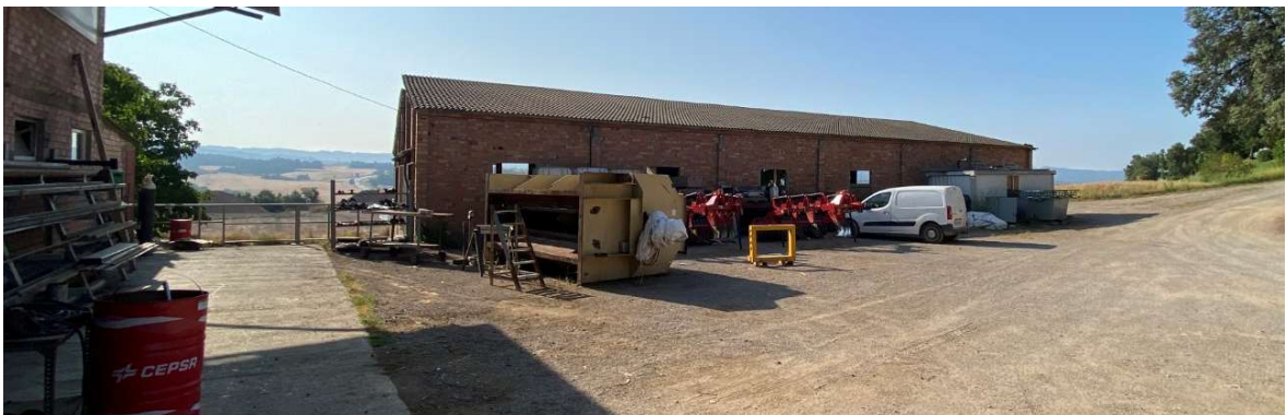
Façana Oest de l'edificació 13. A la dreta, l'edificació 12
