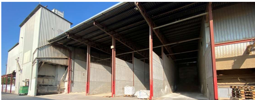
Façana est de l'edificació 7. A l'esquerra de la imatge s'observen les edificacions 5 i 6 (sitges)
