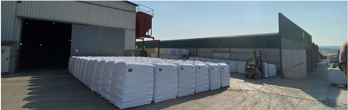
A la dreta, façanes oest i sud de l'edificació 8. A l'esquerra, edificació 4
