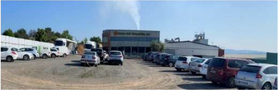
Vista del volum d'oficines des de l'esplanada de l'aparcament
