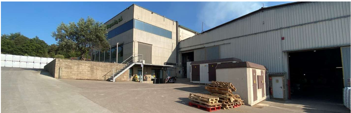
Equips tècnics ubicats davant l'edifici 4. El volum de l'esquerra correspon a les oficines (edificació 1)
