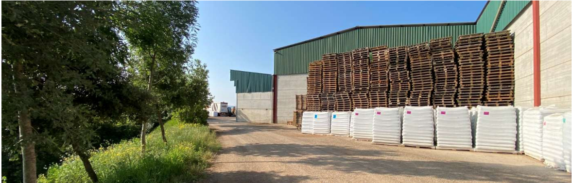
Façana Nord de les edificacions 10 i 11
