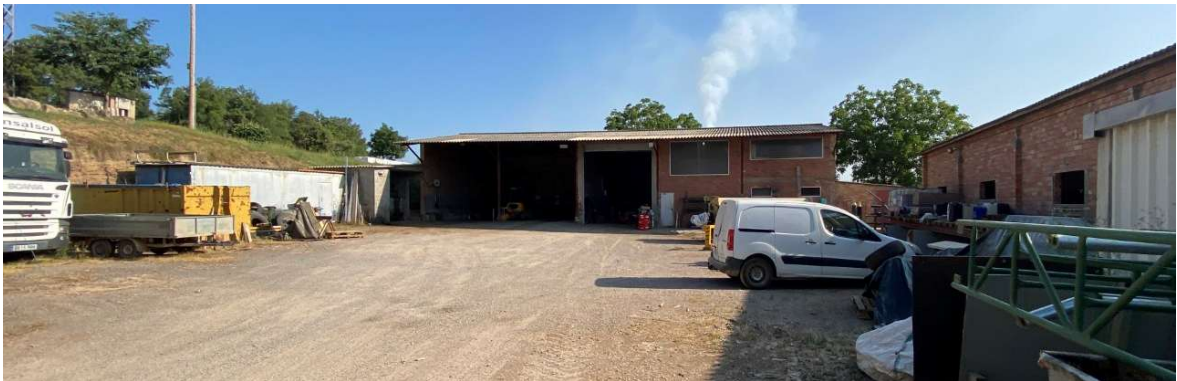
Façana meridional de l'edificació 12. A l'esquerra, l'edificació 13
