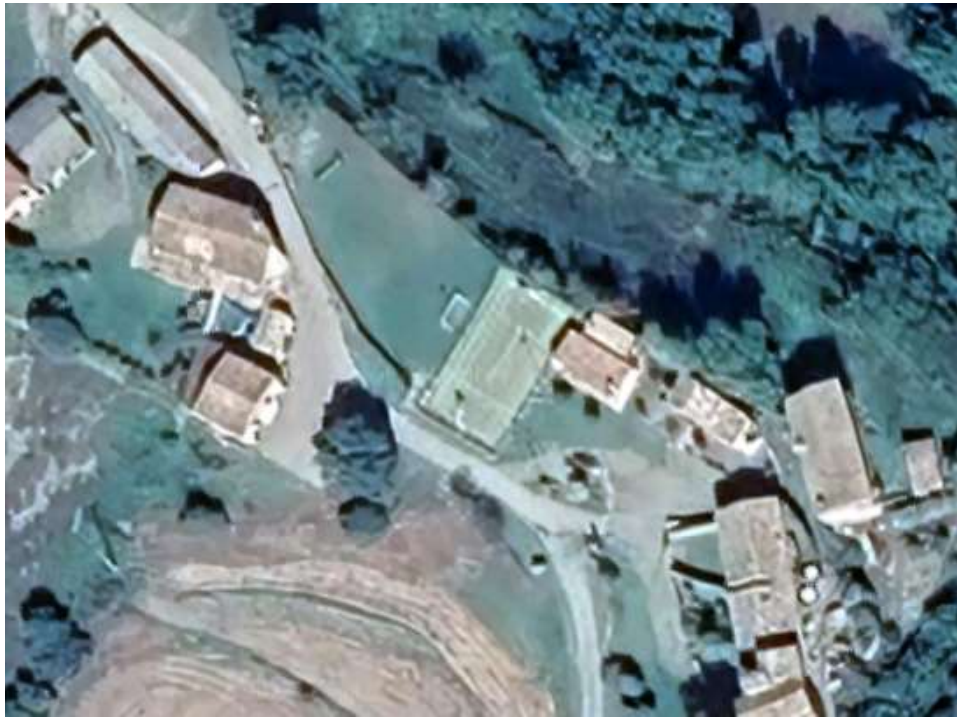
Fig. 2 Vista zenital de la coberta
